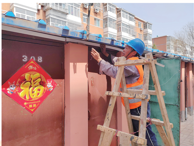
工人正在给小棚亮灯项目布线(香水园街道供图)
